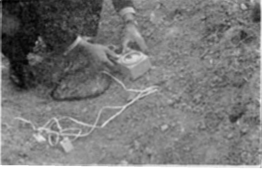
Şekil 23 : Rutubet ölçerle arazide alçı blok direncinin okunması.
