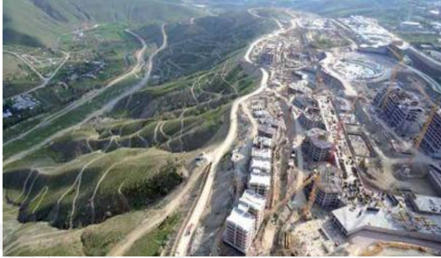
Foto 10. İmrahor Vadisi yamacındaki inşaatlar
