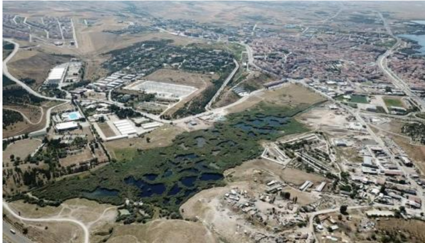
Foto 21. Yapılaşmayla çevrelenmiş Gölbaşı Düzlüğü
